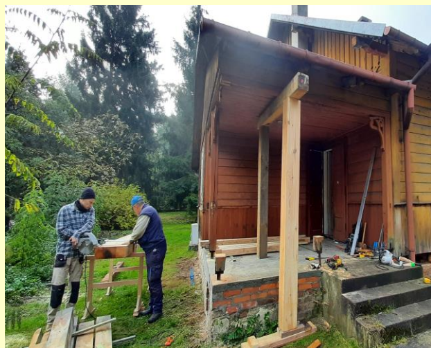
Przykładowe obiekty poddane renowacji i konserwacji. Wymiana podwalin i słupów
